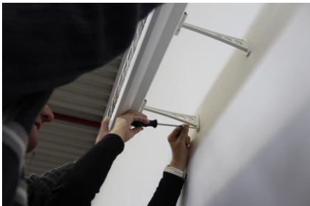
Beide Schrauben jedes Halters einschrauben und mit Schraubendreher festziehen. Eine zweite Person hält den Strahler dabei fest. Put in both screws in each hole and fix them with a screwdriver. A second person should hold the heater during this time.
