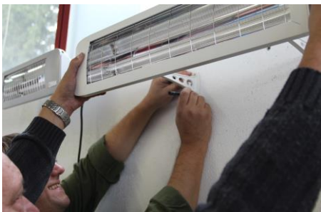
Je zwei Löcher im vorgegebenen Abstand an der Wand anzeichnen/ Mark 2 holes at the specific distances for each holder
